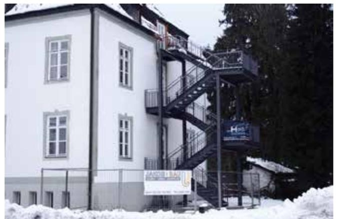
Eines der Ergebnisse der umfassenden Brandschutzmaßnahmen: der im Dezember 2018 errichtete Fluchttreppenturm an der Westseite des Aktionszentrums.
